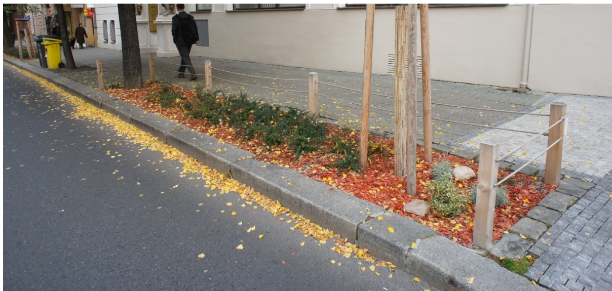
Obr. 7 - dočasné oplocení vegetačních ploch
