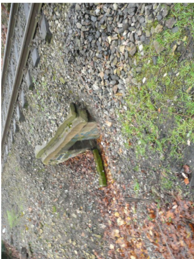
rámový propust na trati
